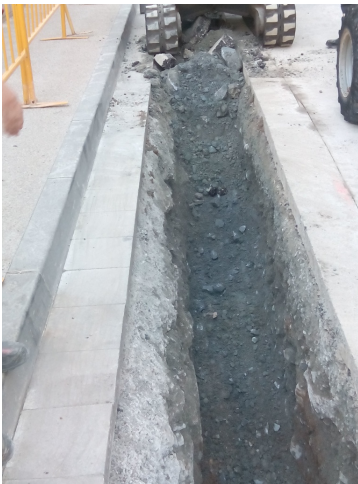
02. Vista del procés d'obertura de la rasa.
