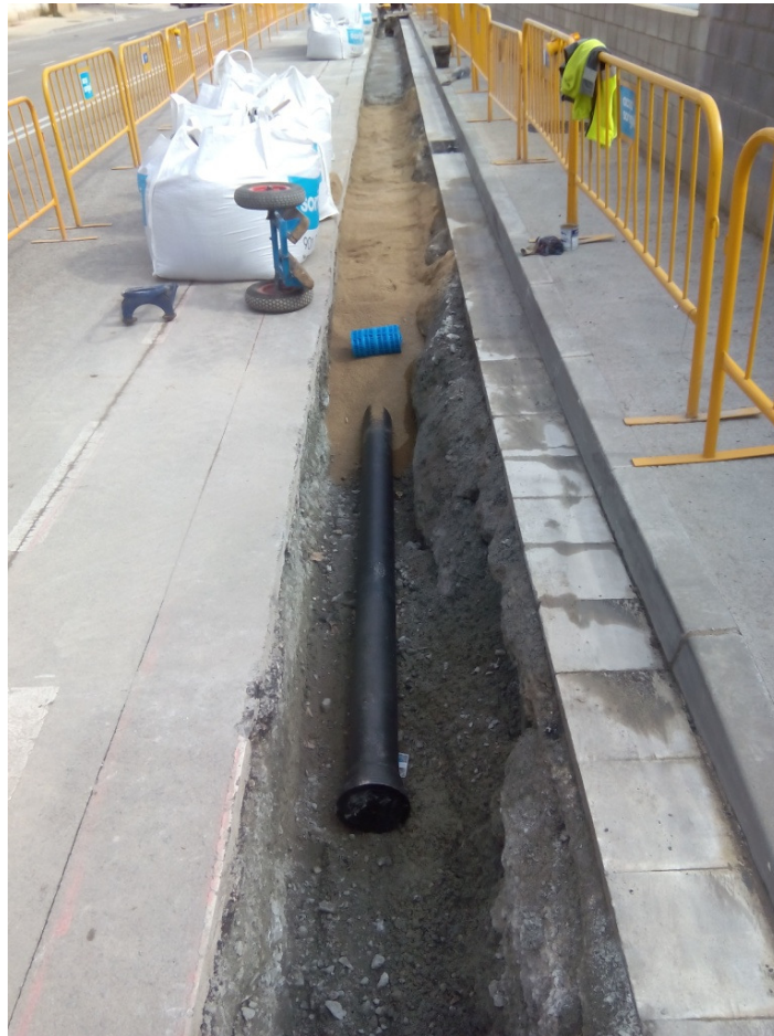
Imatge de la rasa un cop passat la canonada d'aigua.
