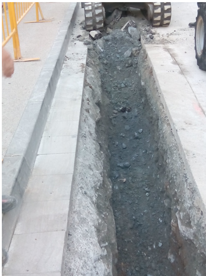
Vista del procés d'obertura de la rasa.
